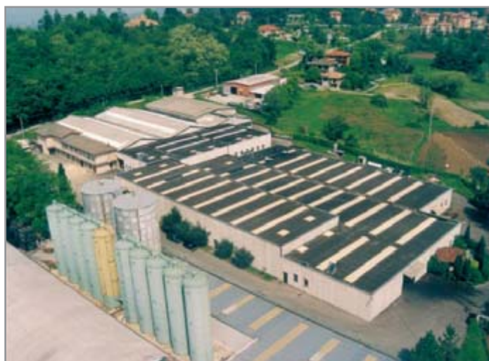
Unità produttiva di Viganò Brianza Production unit of Viganò Brianza
